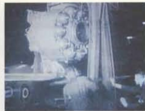
ТУРБОРЕАКТИВНЫЙ ДВИГАТЕЛЬ устанавливается на самолет Глостера-Уиттла E 28/39 весной 1941 г.
